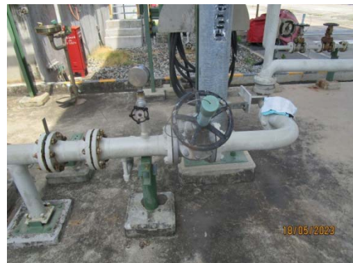
รูปที่ 74 Shut off Valve
