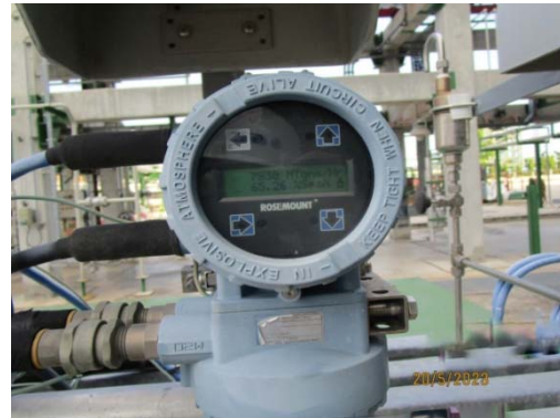
รูปที่ 66 อุปกรณ์วัดอัตราการไหลของสารในท่อ
