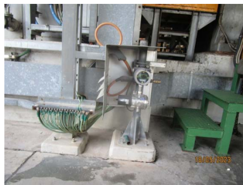
รูปที่ 52 Gas Detector
