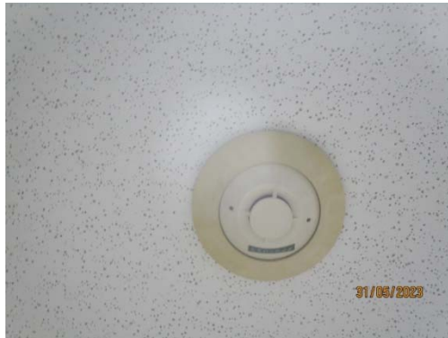
รูปที่ 53 Smoke Detector
