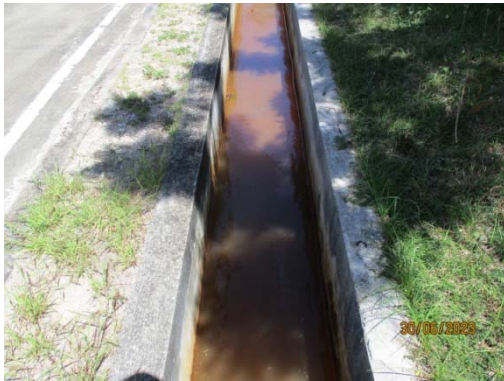
รูปที่ 12 รางระบายน้ำฝนภายในพื้นที่โรงงาน ที่แยกออกจากรางระบายน้ำเสีย
