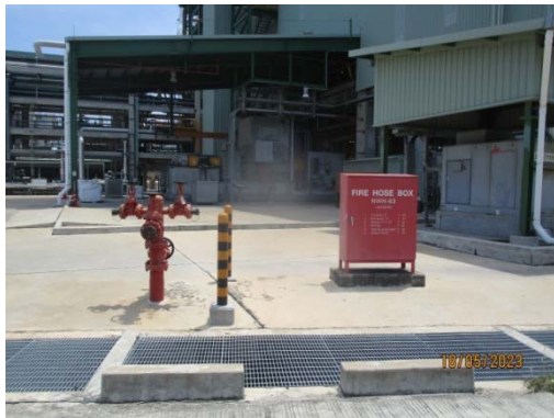
รูปที่ 49 Hydrant และ Hose box
